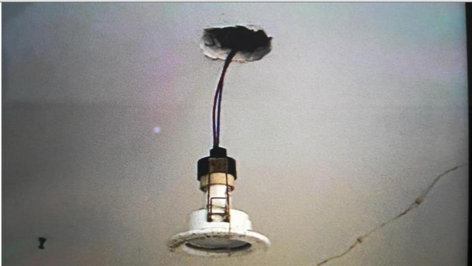
Description : L'installation électrique comporte au moins un dispositif de protection avec une partie active nue sous tension accessible.
